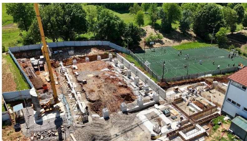
Slika 7. Izgradnja školske sportske dvorane, OŠ Generalski Stol
