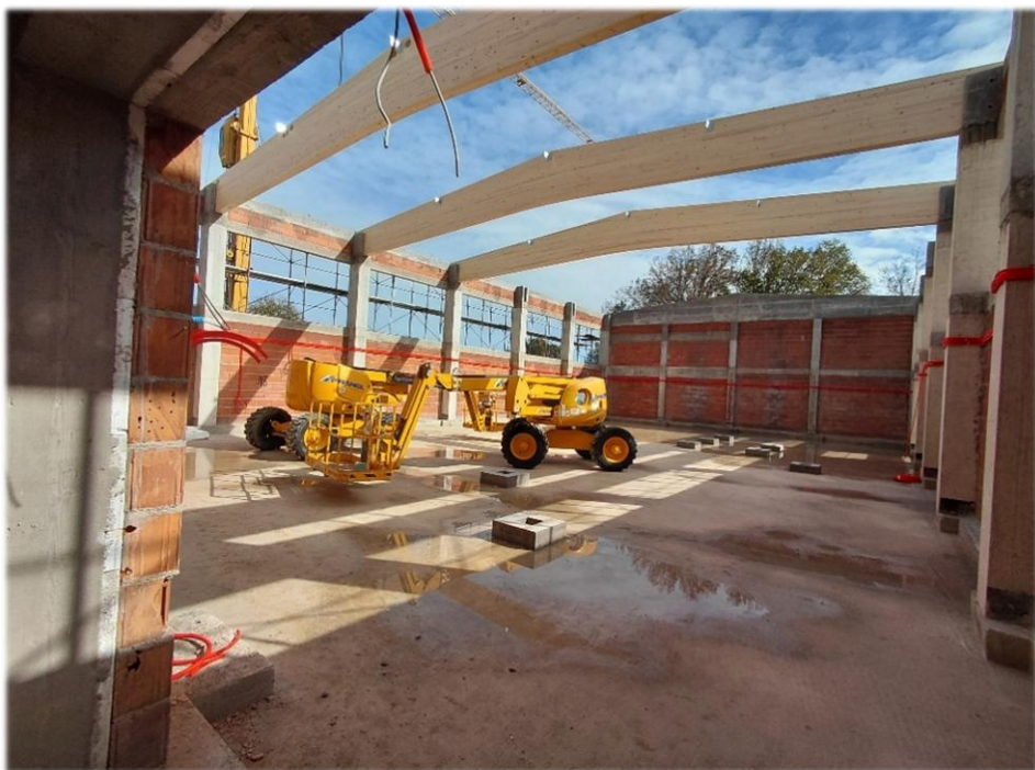
Slika 7. Izgradnja školske sportske dvorane, OŠ Generalski Stol
