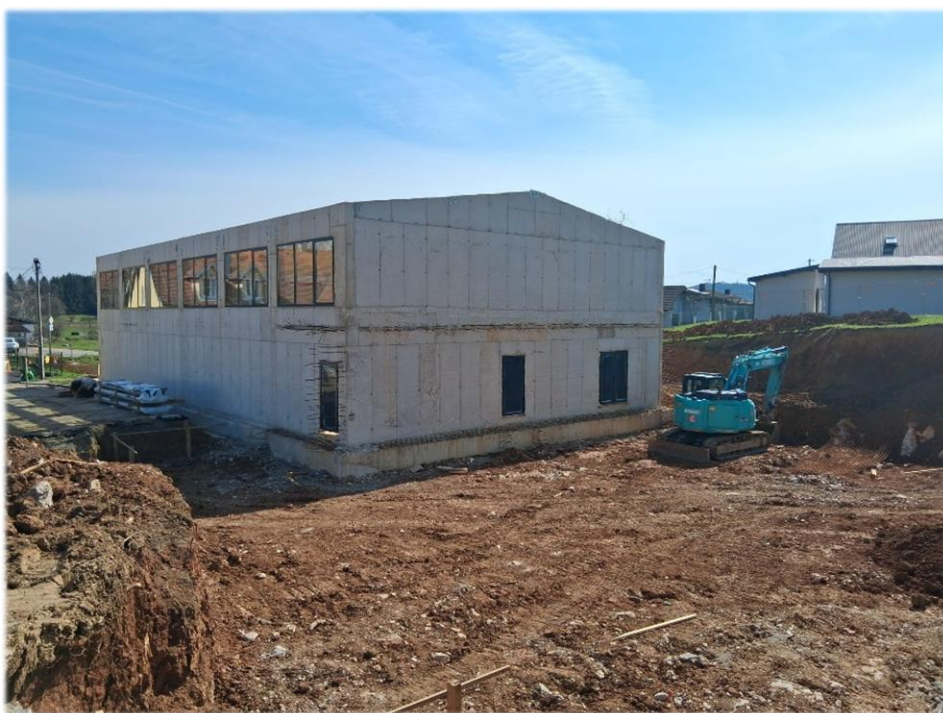
Slika 8. Izgradnja školske sportske dvorane, PŠ Oštarije
