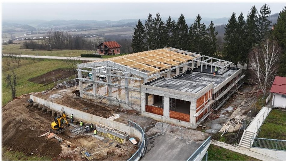
Slika 3. Dogradnja školske sportske dvorane, OŠ IGK Duga Resa
