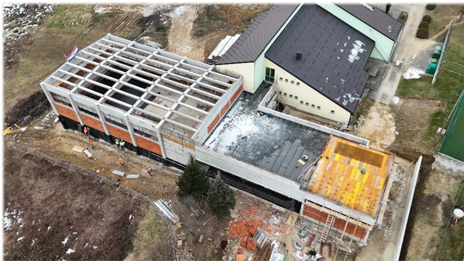
Slika 5. Izgradnja školske sportske dvorane OŠ Cetingrad
