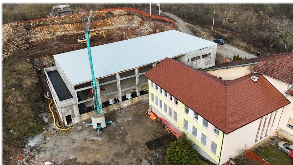
Slika 6. Dogradnja školske sportske dvorane OŠ Barilović
